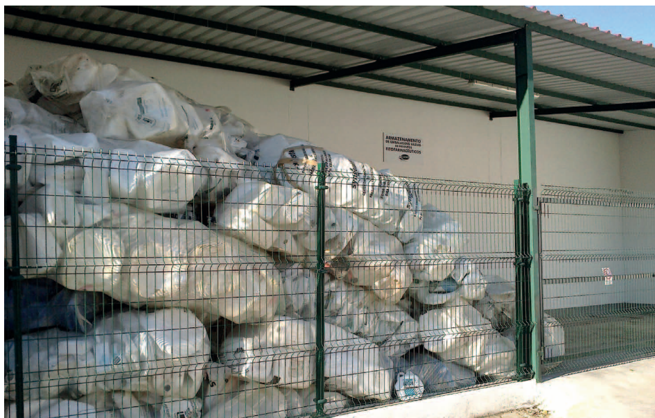
A A. Cano investiu num local apropriado para armazenamento das embalagens vazias de produtos fitofarmacêuticos, posicionado no exterior, mas com cobertura e piso cimentado
